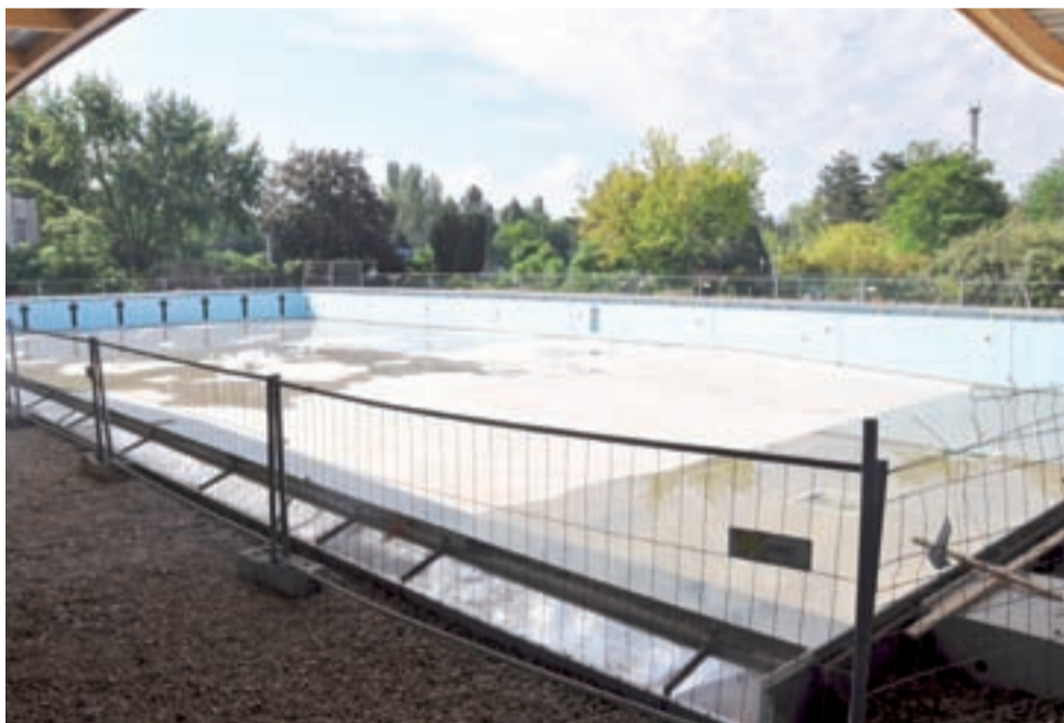
Le Centre d'entraînement et de formation à la natation de haut niveau, en travaux au mois de juin
