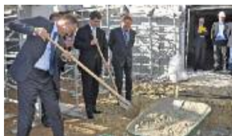
4 octobre : Pose de la première pierre de la Résidence Seniors au Trident.
