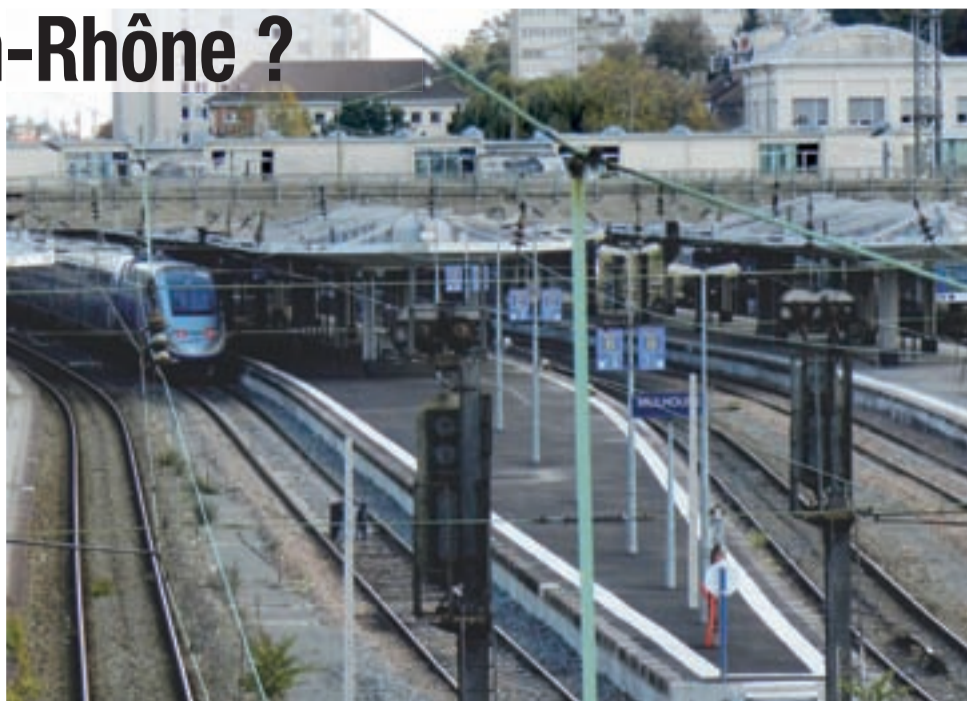
RFF a rénové le «quai des TGV» en Gare de Mulhouse (voies 6 et 7)
